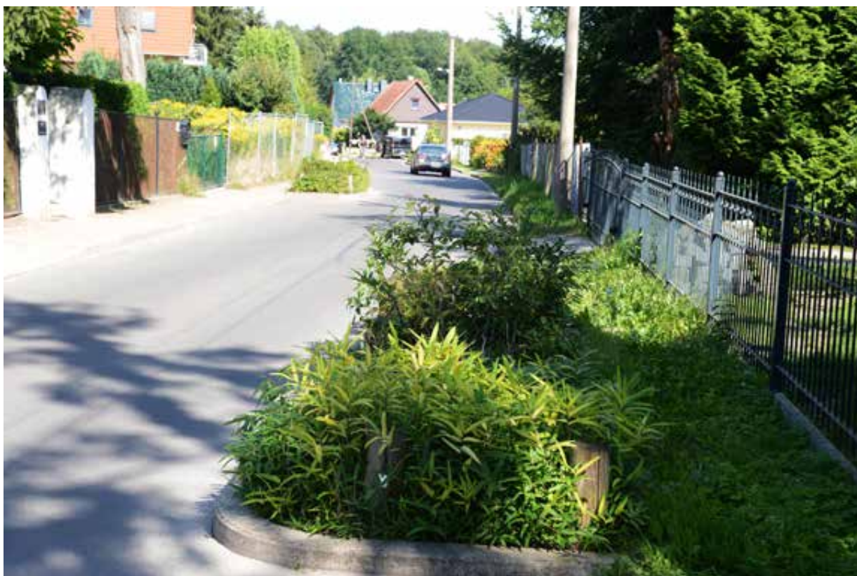
Overvannet fra vegen infiltreres i «park-lommer» langs vegen i Tyskland. Foto: Christen Ræstad
