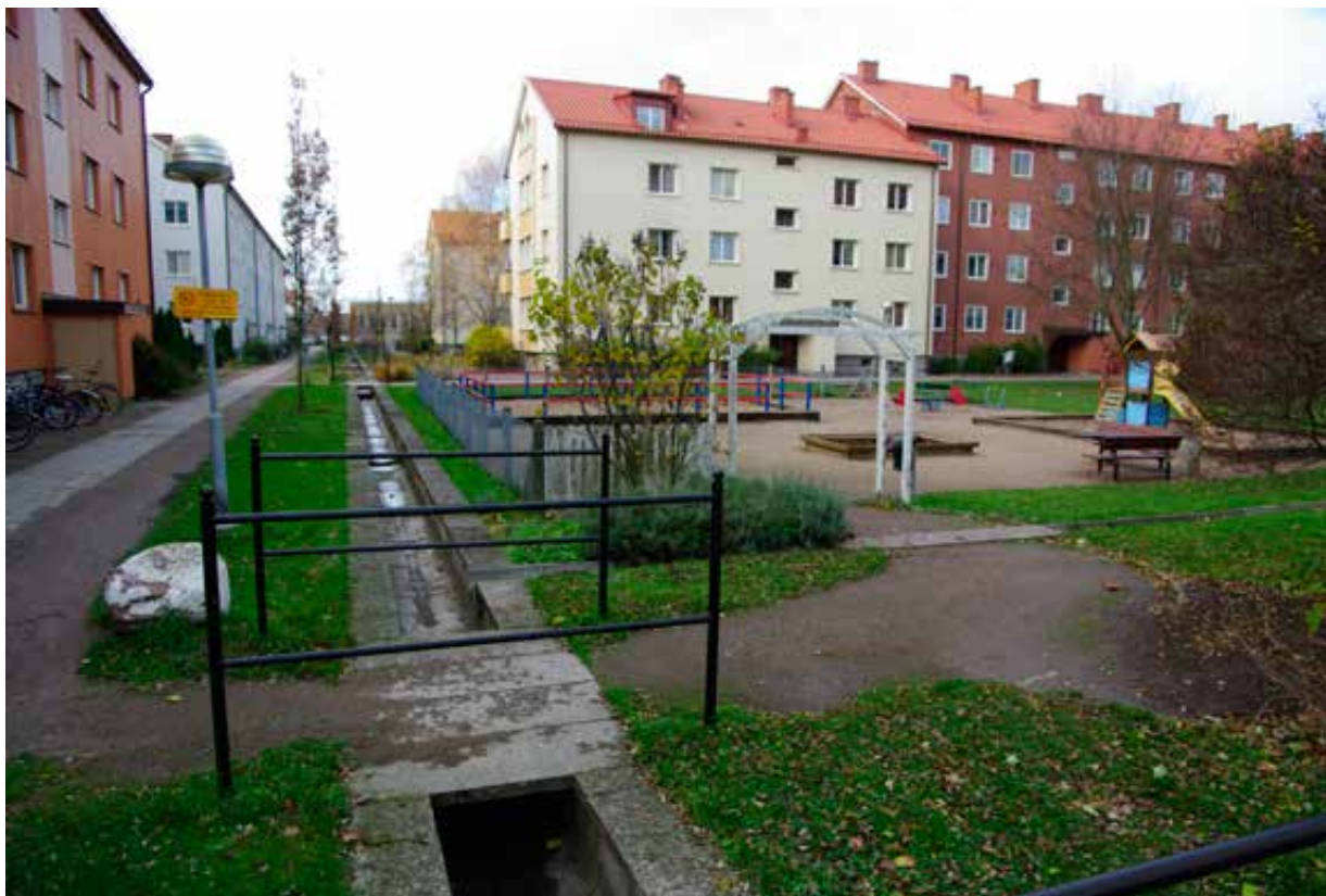
Malmö kommunen var tidlig ute med å bygge løsninger med åpne vannveier. Bildet er fra Augustenborg i Malmö der et boligområde med eldre blokkbebyggelse ble renoveret, og da ble overvannshåndteringen ombygget til åpne løsninger. Foto: Christen Ræstad
