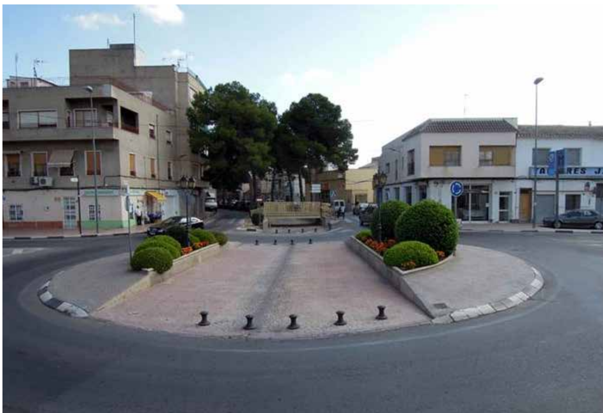
Syd-Europa har mange års erfaringer med ekstrem nedbør. De få gangene det regner, føres overvannet vekk på overflaten, tvers gjennom rundkjøringen i byens sentrum. Fra Pinoso i Spania 2011. Foto: Christen Ræstad
