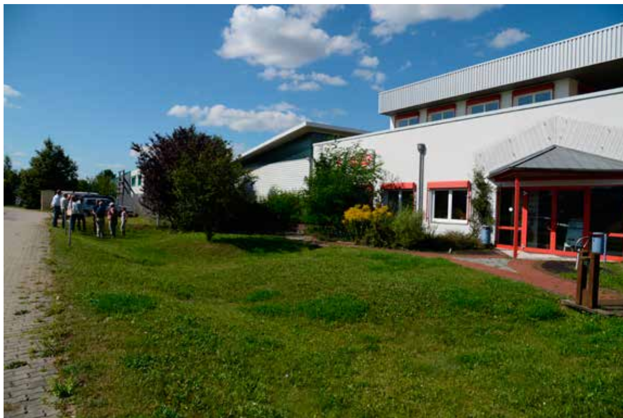
Fra Danmark der brede overvannsgrøfter med infiltrasjon mellom bygningene og vegen tar hånd om overvannet fra alle arealene.
